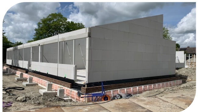
De kalkzandsteenblokken worden gelijmd
