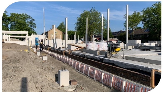
Het metselwerk wordt eerst tot maaiveld opgemetseld
