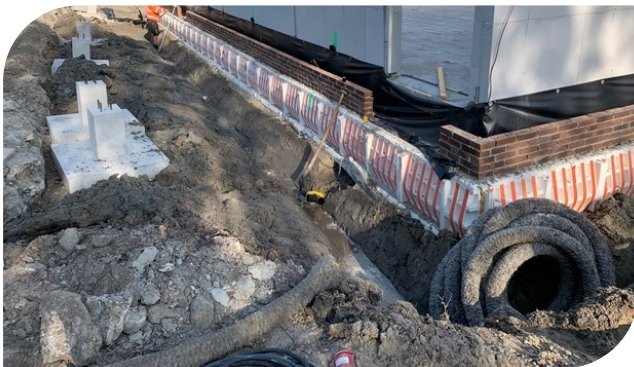
De drainage onder het gebouw wordt rondom gekoppeld
