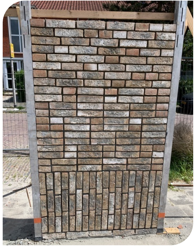
De proefmuur, hij wordt nog ingevoegd en beoordeeld
