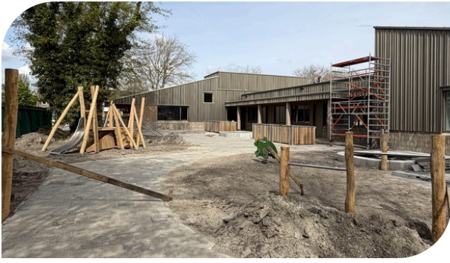
Plein Wille en It Twalûk in aanbouw
